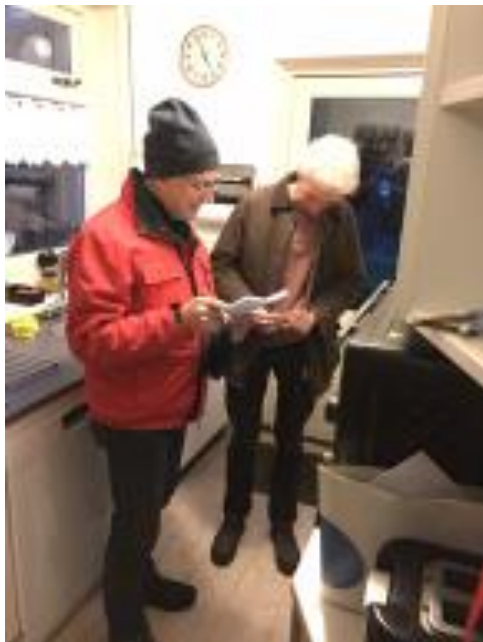
Linthorst Techniek deed een opname van de huidige installaties in enkele woningen in de Benedenbuurt.
